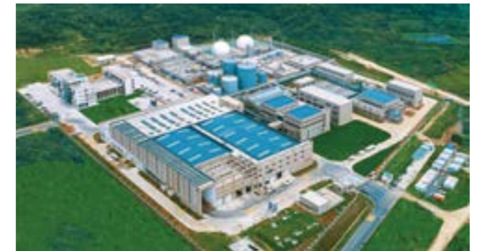
南京江北废弃物综合处置中心
