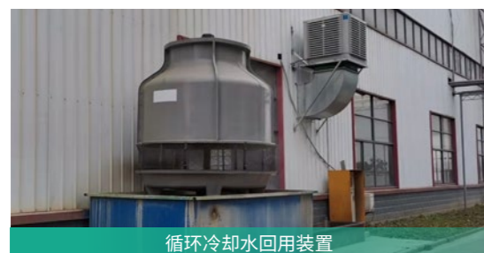
循环冷却水回用装置
