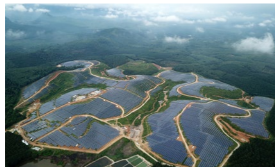
马来西亚 62MWp 光伏电站项目
